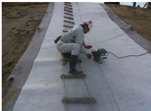
写真-10 斜面溶着状況
