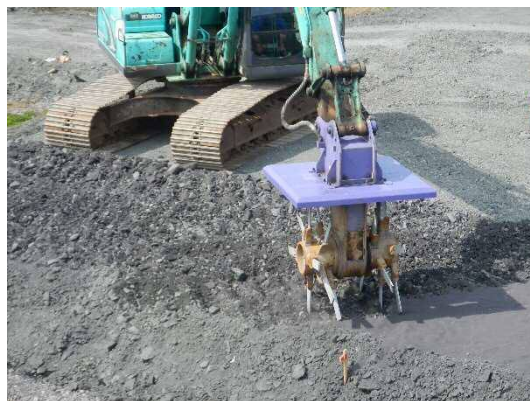
写真-2 スタビライザによる混合
