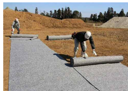
写真-5 保護マット敷設
