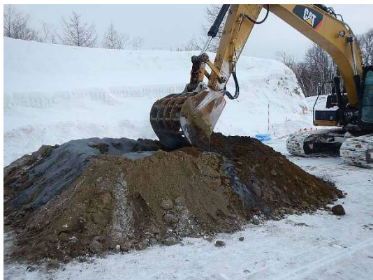
写真-1 ミキシングバケットによる混合
