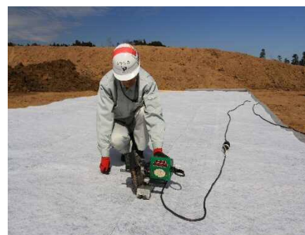
写真-7 吸着シート溶着
