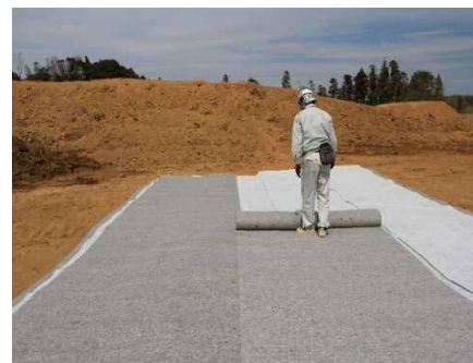
写真-8 保護マット敷設
