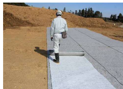
写真-6 吸着シート敷設
