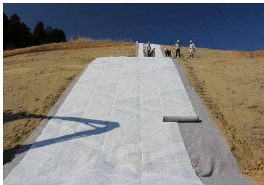
写真-9 斜面敷設状況
