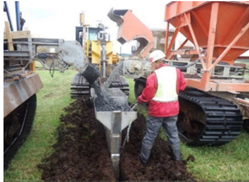
疎水材2種類投入状況
