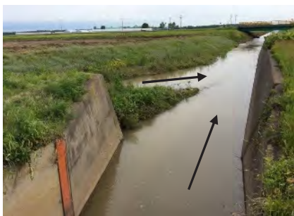
写真-1 合流地点から下流方向 （右は擁壁A、左は擁壁B、手前は取付水路、奥に町道橋が見える）
