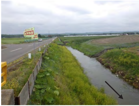
写真-6 町道橋より上流方向 (左は町道田浦・二宮1線および自立山留め式擁壁)
