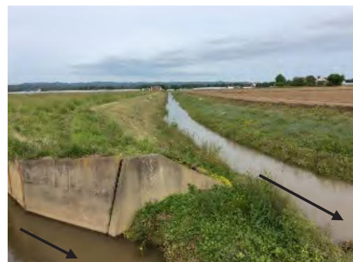
写真-5 合流地点から上流方向 （左は擁壁B、取付水路）
