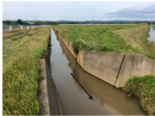
写真-2 合流地点からポロクラ川上流方向 （左は擁壁A、右は擁壁Bと取付水路）
