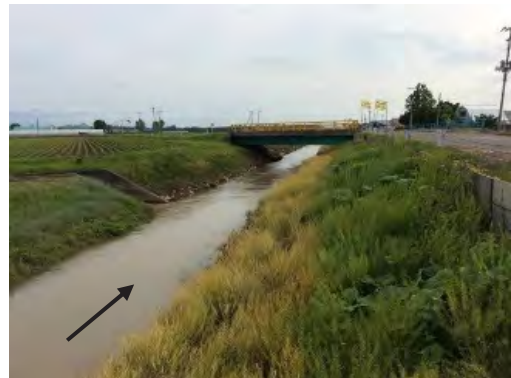
写真-3 擁壁Aから下流方向 （奥が町道橋、右は町道田浦・二宮1線）
